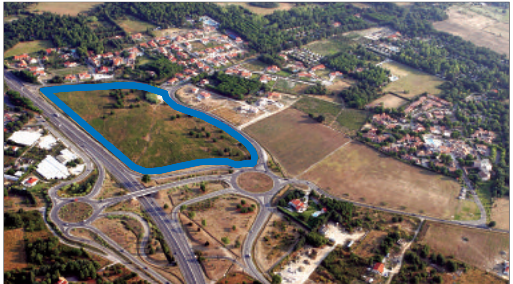
Vue aérienne du terrain du futur lycée, terrain concerné par la révision simplifiée du P.O.S.
