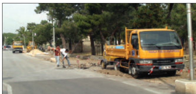
Travaux de réfection du revêtement du parking des Pins
