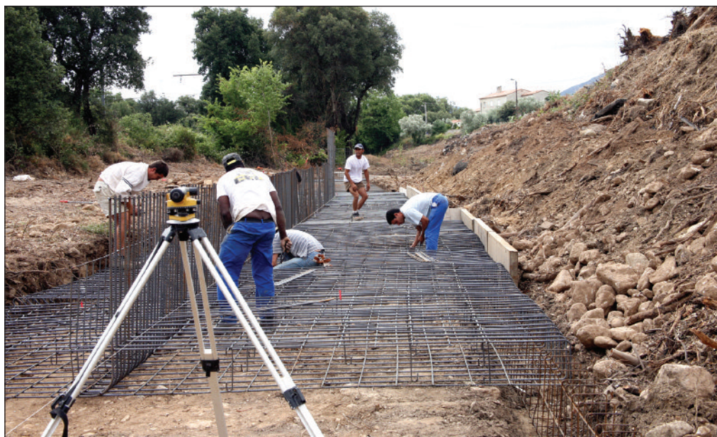
Rue des Cyprès, l'Office public HLM vient de démarrer les travaux d'aménagement en vue de la construction d'un ensemble immobilier qui comportera 64 logements répartis en 12 F3, 32 F4 et 20 F5.
