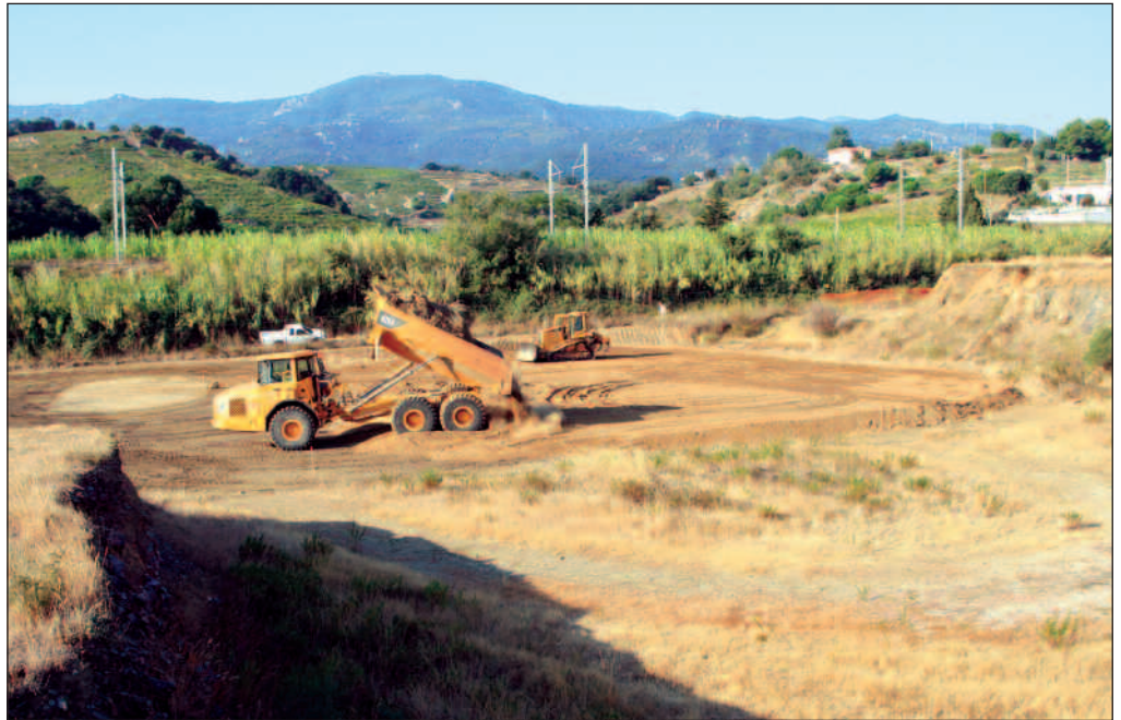
En contrebas des rochers de Porteils, le terrain est en cours d'aménagement pour la création du parking. Toute circulation motorisée sera interdite sur le reste du site.
