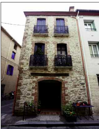
Rénovation rue de la République
