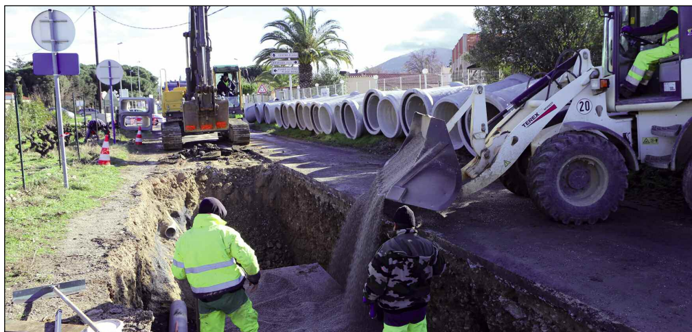
Parmi les investissements poursuivis en 2013, l'aménagement du chemin de Neguebous dont les travaux seront terminés au printemps.
