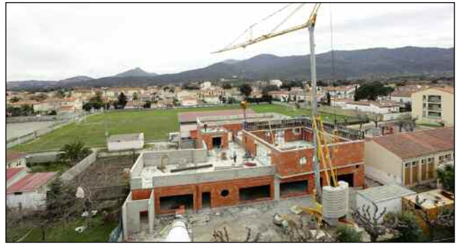
Construction du restaurant scolaire Curie-Pasteur
