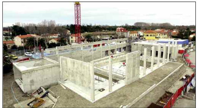
Construction de la piscine communautaire
