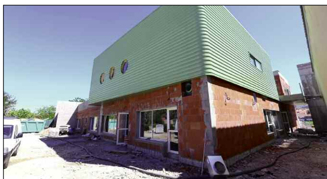
La construction de la cantine Curie-Pasteur.
