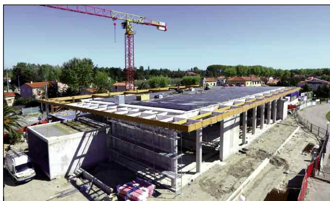
Les travaux de la piscine communautaire.
