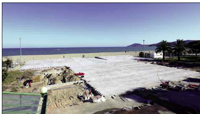
Centre-Plage : fin des travaux en mars.
