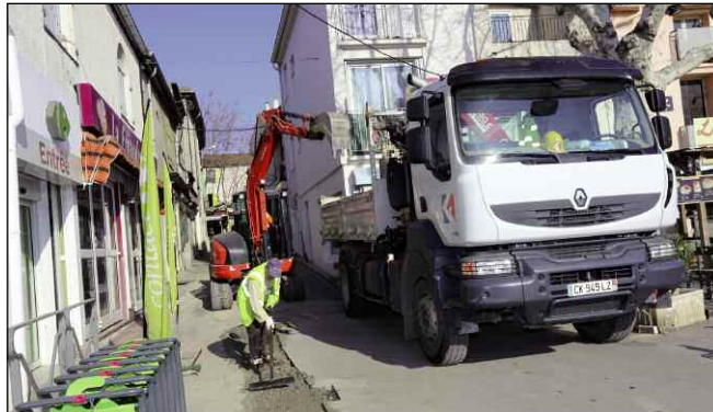
Travaux de renforcement électrique en centre ville.
