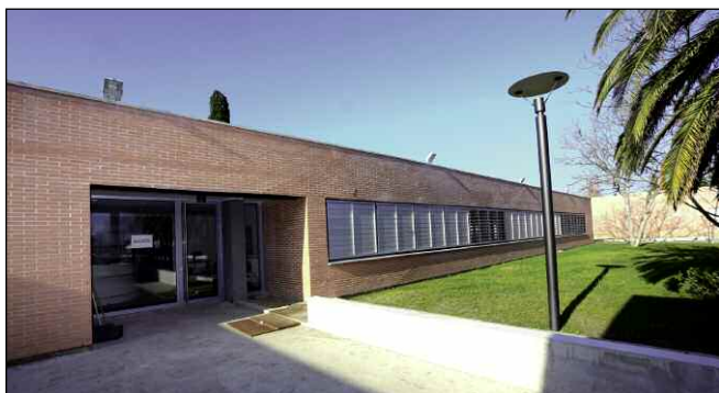
Réhabilitation du collège des Albères (Conseil général).
