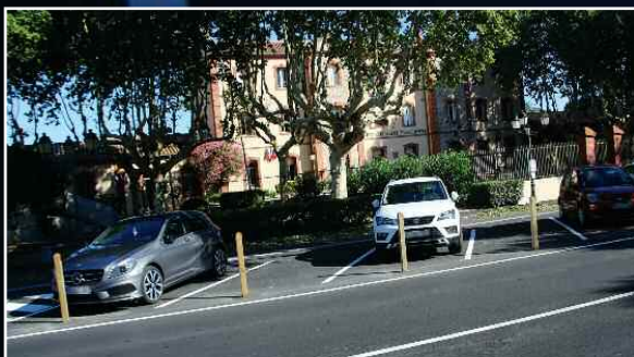
Dernière tranche de travaux programmée, le parking qui longe l'Hôtel de Ville sera aménagé après la haute saison touristique : travail sur les réseaux, bitumage.
