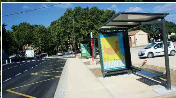
L'arrêt de bus situé devant l'Hôtel de Ville est déplacé près du service Accueil de jour l'Albe. Accessible aux personnes à mobilité réduite, il sera à terme arboré. La rue Ferdinand-Buisson va bénéficier sur toute sa longueur d'un nouvel éclairage public. Enfin, la sortie de l'Albe a été déplacée côté Cami Trenca.
