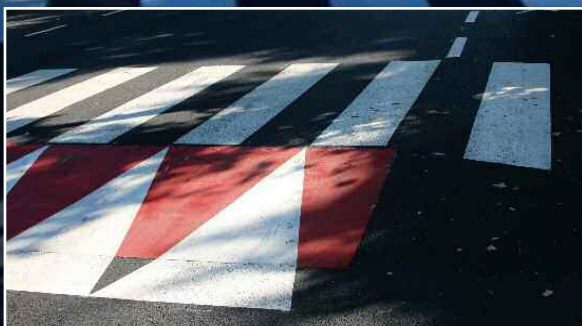
La portion de la rue Ferdinand-Buisson, entre l'Albe et le passage à gué de la Massane, a fait l'objet d'importants aménagements d'embellissement et de sécurisation : mise en place de coussins berlinois pour « casser » la vitesse ; réalisation d'un plateau traversant entre la passerelle et l'Hôtel de Ville ; création d'un petit giratoire et d'une troisième voie de circulation fluidifiant l'accès à la route Nationale.
