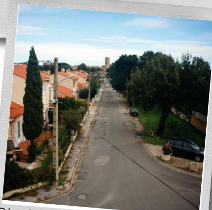
Réaménagement de la route de N-D-de-Vie (programme de voirie)
