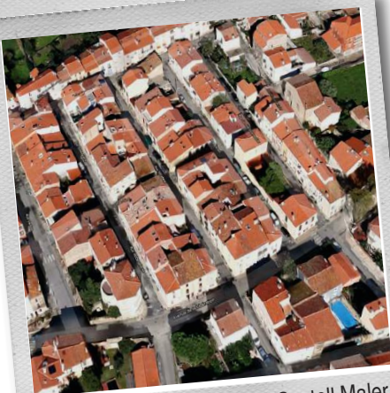
Rénovation voirie quartier Castell Maler (programme de voirie)
