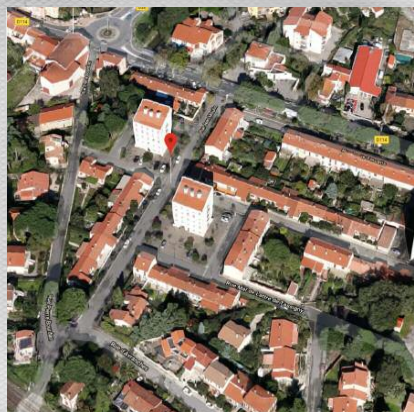
Rénovation voirie quartier Jean Moulin (programme de voirie)
