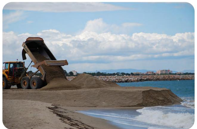
Le rechargement est achevé. Le sable va désormais faire sa vie au gré de la mer et du vent, sous l'œil des scientifiques. Depuis juillet 2020, dans le cadre de l'Obscat, le site du Racou dispose en effet d'une caméra vidéo haute fréquence qui permet un suivi topobathymétrique (déplacement de sable de la partie émergée et immergée de la plage).
